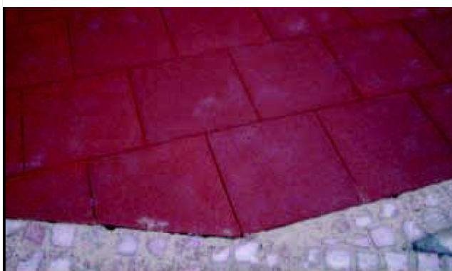
Rysunek 11. Dokładnie dopasowane płyty
