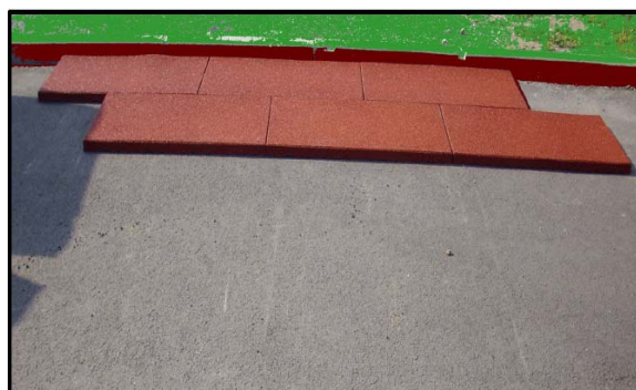
Rysunek 14. Układaj warstwę dolną
